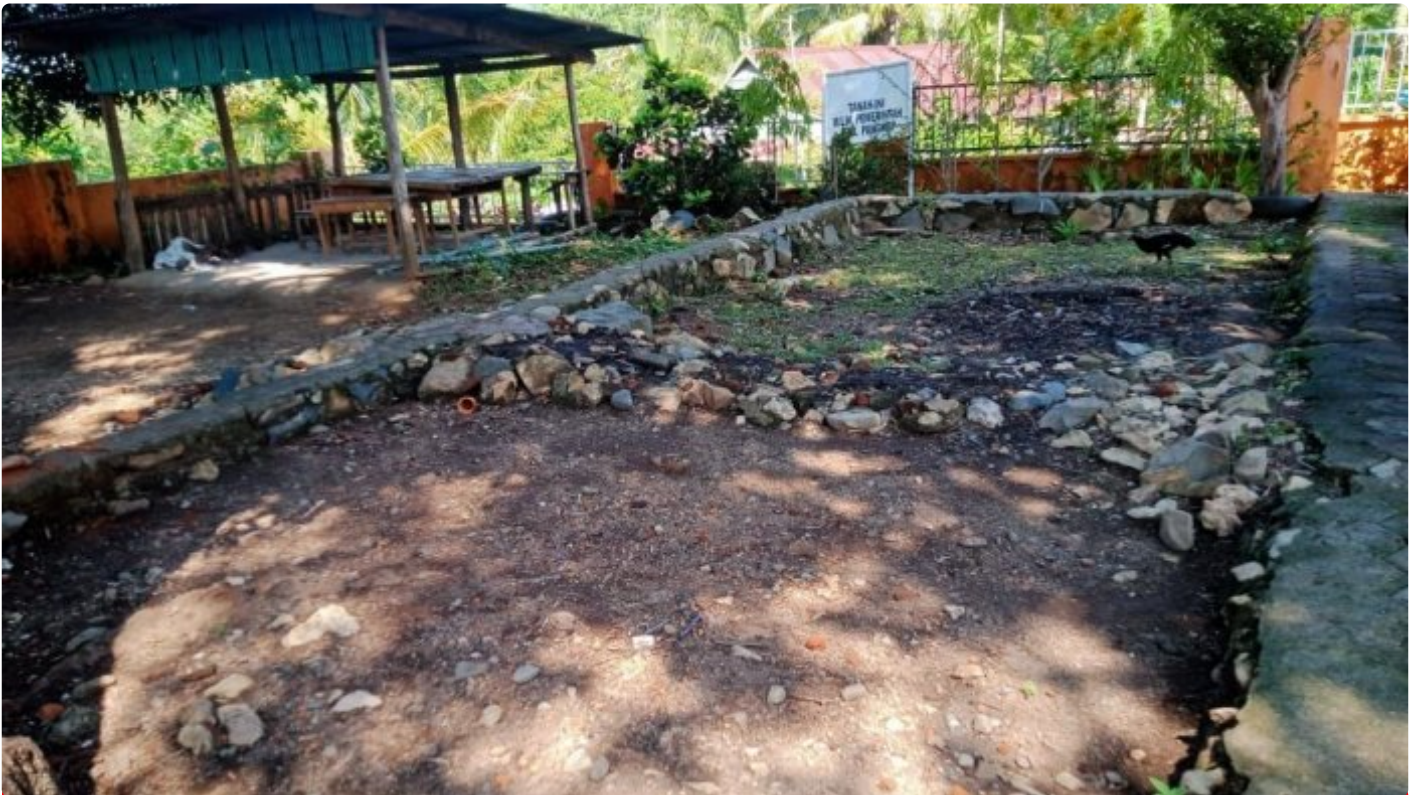
Macet, Baru Pondasi Bangunan Musholla selesai di SDN 19 Batu Napara Balocci
