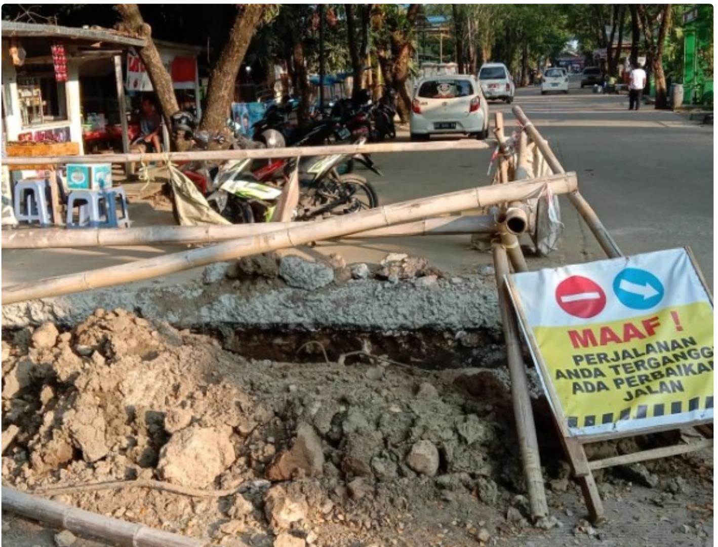
Jalan Cendana dibongkar dan belum dilanjutkan pekerjaannya
