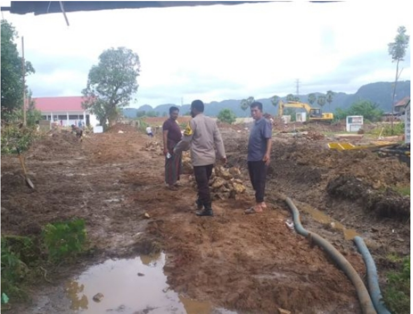
Bhabinkamtibmas desa Kabba monitoring pekerja pembongkaran jalur kereta api
